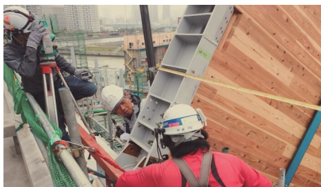
CLT 屋根の施工風景 [提供: 東急建設]
