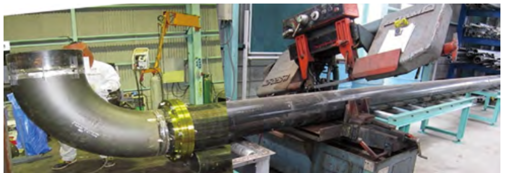
配管工場で大口径の鋼管切断加工・継手にフランジを溶接する様子
