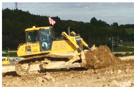
マシンコントロールのブルドーザーによる施工
