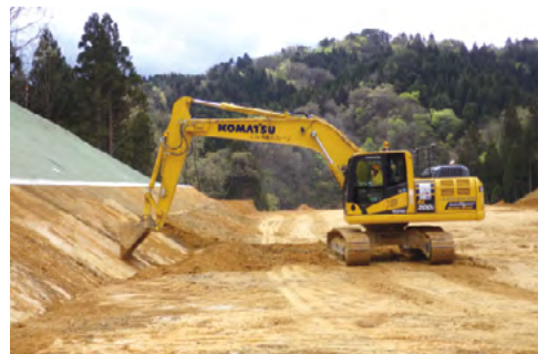
設計面の LandXML データ(左)と、マシンコントロールバックホーによる施工(右)
