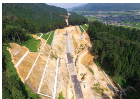
ICT を全面活用した道路土工の現場
