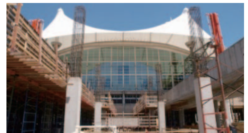
既存ターミナルに隣接したホテルの建設現場。タワークレーンが工事の主役だ
