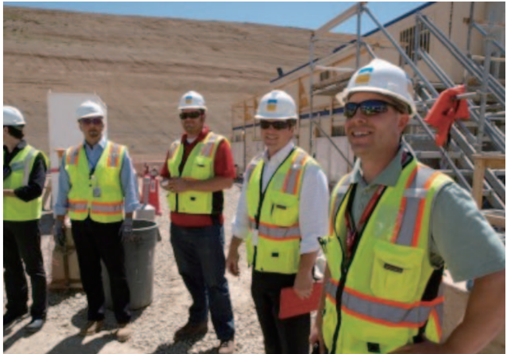
現場の施工管理を担当する技術者。オートデスクの担当者も現場で工事関係者にBIM/CIMソフトの使い方などをアドバイスしている
