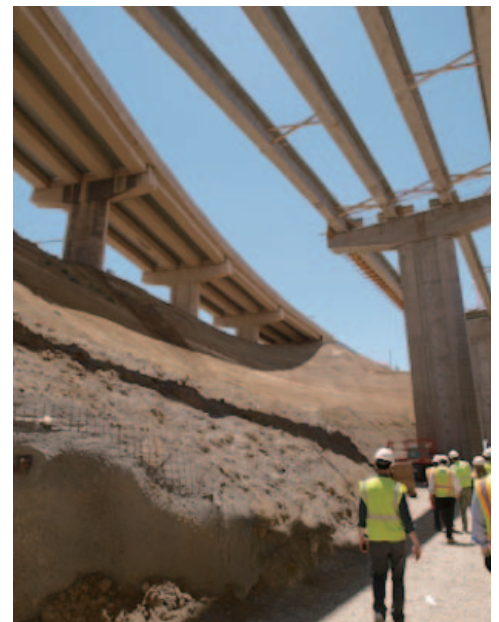
現場の地盤高低差は大きく、橋梁が複雑に交差している。トラッククレーンなどの進入路も3次元での検討が必要だ
