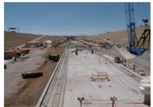
周囲を斜面に囲まれた鉄道駅の施工現場
