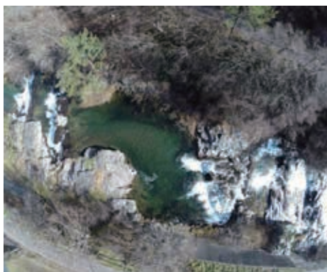
ドローンで撮影した大川七滝の写真。どこに橋を架げるかも重要な検討項目だった
