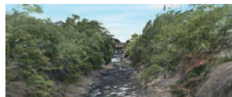
TINデータ上に空撮写真の色を載せて作った渓谷のCIMモデル。樹木下の渓谷までしっかりと3D化されている。樹木はあえてフィルタリングせずに残した
