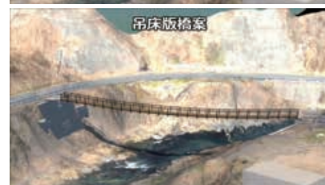
3つの橋梁形式の検討。様々な角度や視点からの景観を検討した結果、片塔式吊り橋案の採用となった
