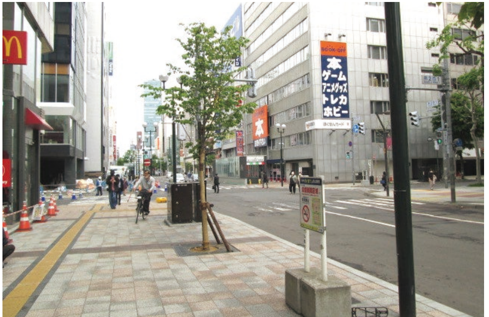
元通りの位置に復旧された歩道
