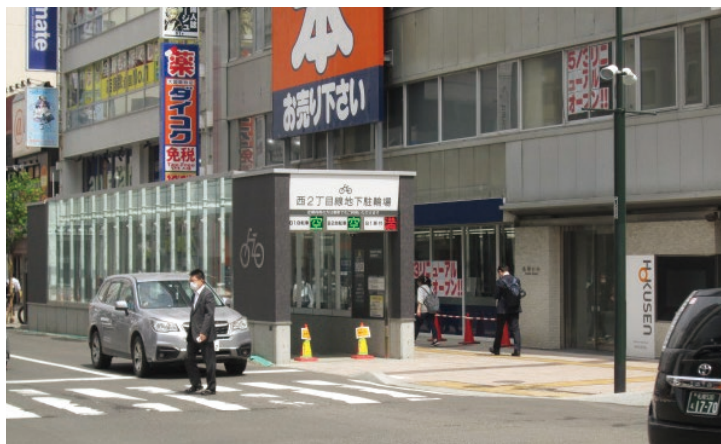
イメージ通りに完成した出入口
