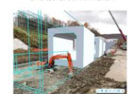
掘削作業時にARと比較
