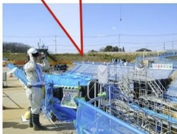
HoloLensを善けた施工管理者(左)は、これから建てる構造物を現場の風景に重ねて見ることができる
