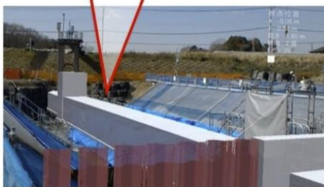
HoloLensを善けた施工管理者(左)は、これから建てる構造物を現場の風景に重ねて見ることができる
