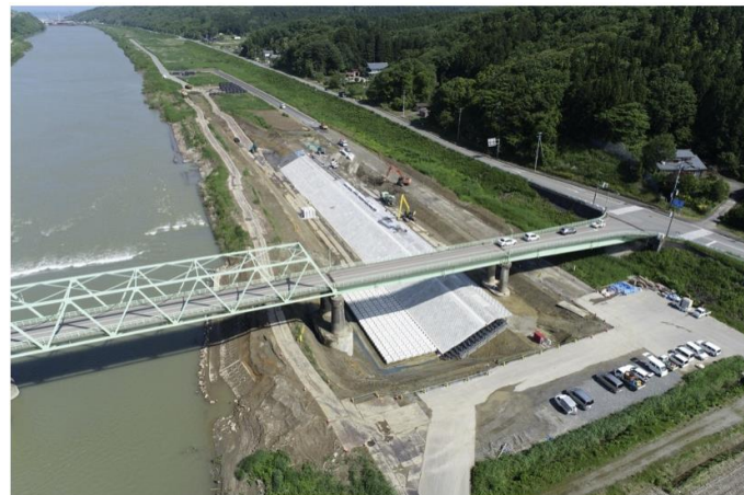
4Dシミュレーションと同様に進む実際の現場
