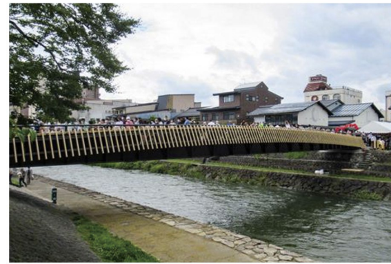
高山市の行神橋。完成後の現地写真
