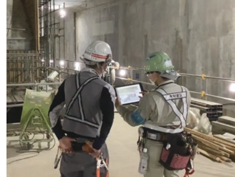
現場でタブレットの BIM モデルを確認する職人
