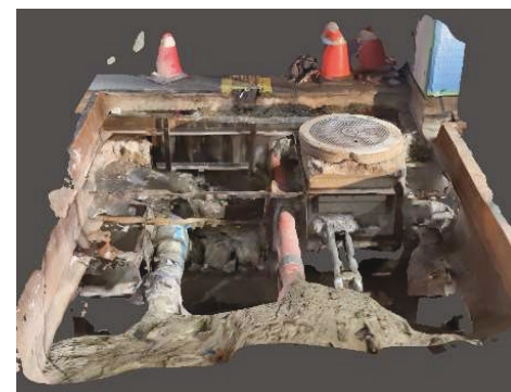
iPhone で計測した現場の点群データ。埋設管などの仮受け状態などがよくわかる
