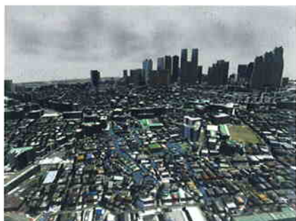
集中豪雨が都心で発生した場合の内水氾濫イメージ (高層ビルデータ提供：朝日航洋)
