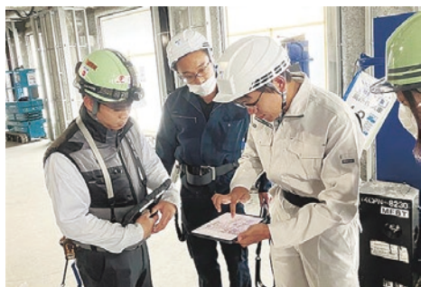
模範となるB棟現場のBIM活用
