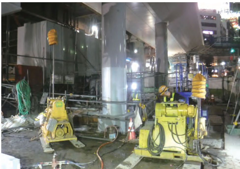
東京・渋谷駅付近で行われた薬液注入工事
