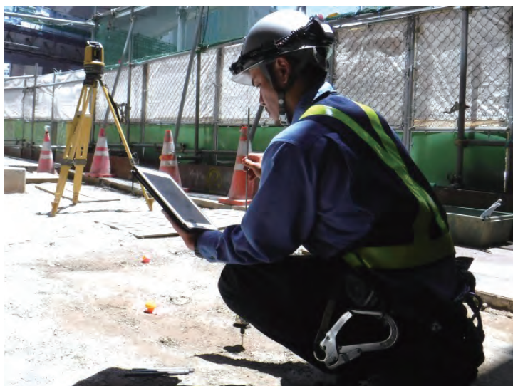
Point Layoutを使った墨出し作業のイメージ。奥はトプコンの測量機「LN-100」
