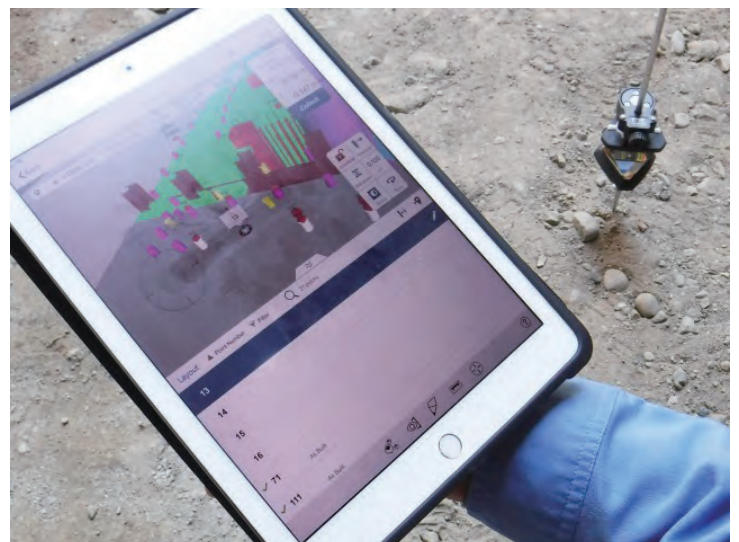
タブレットの画面には、墨出しを行うポイントまでの方向と距離を3Dモデル上にわかりやすく表示する
