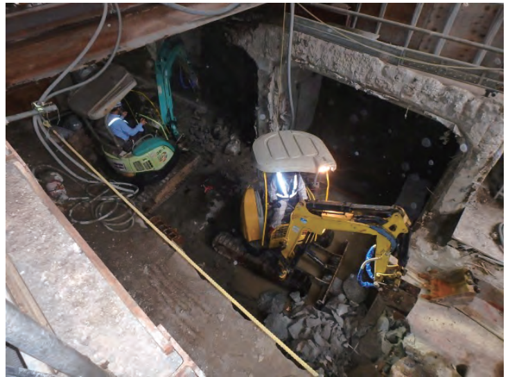
改良された地盤から掘り出された橋台
