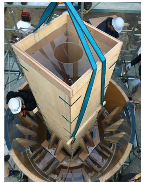
土木と建築の接合(杭)施工。左の絵の実際施工の写真
