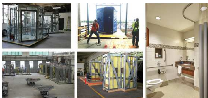
図14: バスルームユニット(POD)のプレハブ化
