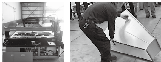
①レーザー切断機と熟練工によるダクト加工
